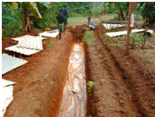
Enkelt biogassanlegg legges ned i bakken
